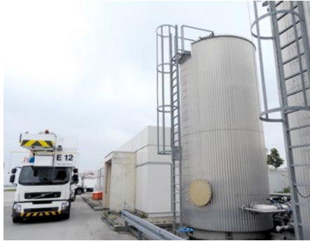
Enteiserfahrzeug an einer Befüllstation
