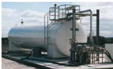
Sichere Standflächen mit Geländern
