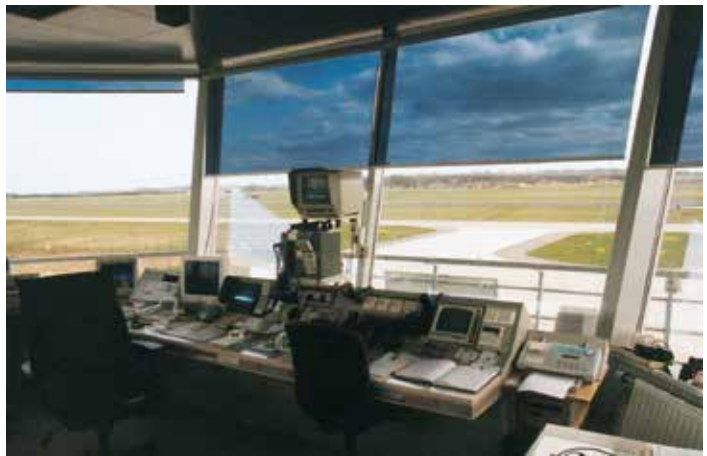
Fenster mit Blendschutz
