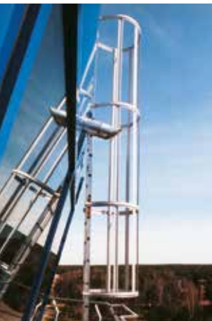
Steigleiter mit Sicherung gegen Absturz
