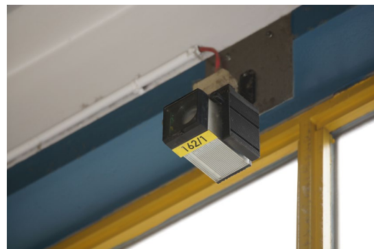
Abb. 35 Lichtschraken-Rauchmelder
