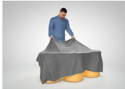
2 Abdecken verbliebener brennbarer Stoffe
