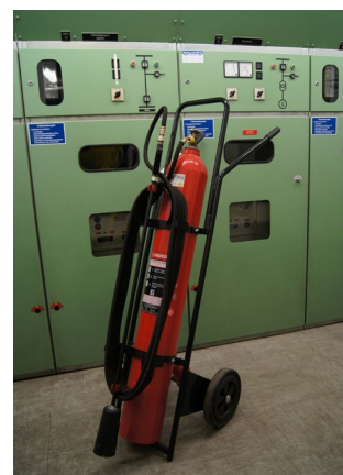
Abb. 45 Fahrbarer Kohlendioxid-Feuerlöscher
