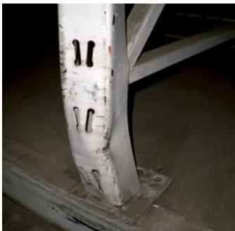
Abb. 12 Gerissene Schweißnaht an der Fußplatte der Stütze
