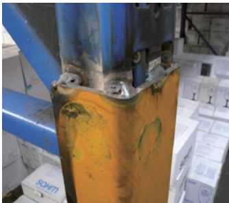
Abb. 11 Unfachmännisch geschweißte Stütze
