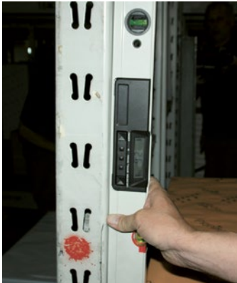
Abb. 10 Messung der Schiefstellung mit digitaler Wasserwaage
