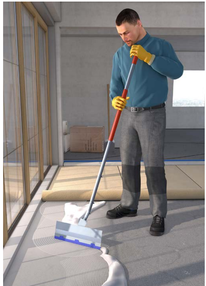
Abb. 20 Aufrechte Körperhaltung durch Einsatz eines Teleskopstiels
