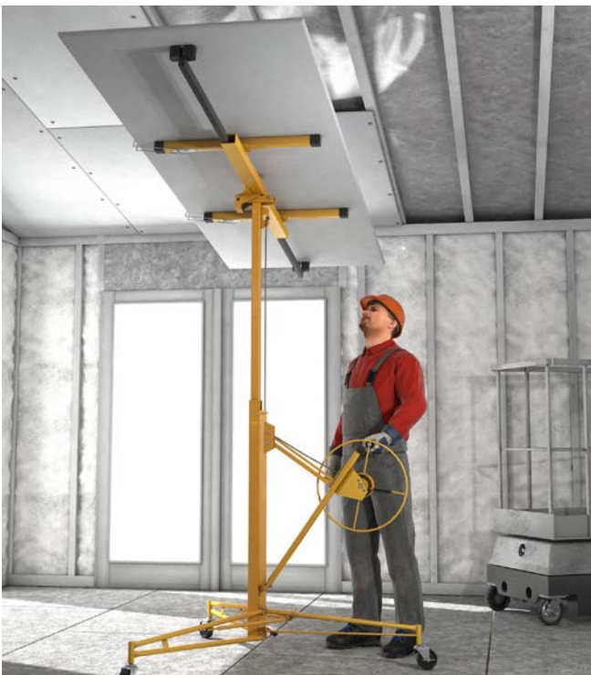
Abb. 24 Ein Platten-Montagelift entlastet das Hand-Arm-System und die Wirbelsäule durch Vermeidung von Ganzkörperkräften.
