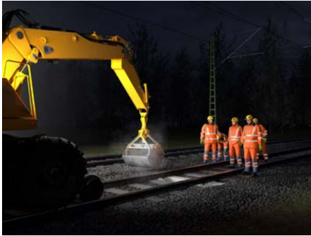
Abb. 22 Gleisoberbauarbeiten: Empfehlung Warnkleidung Klasse 3
