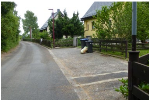
Abb. 3 Einspurige Straße mit Ausweichstelle
