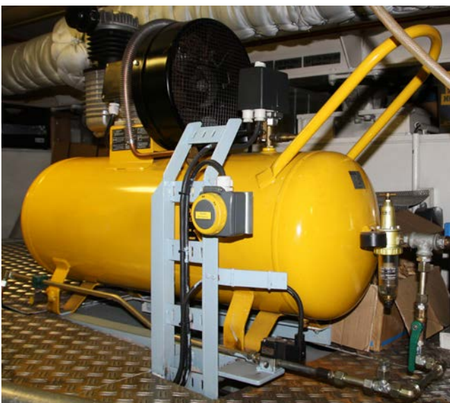
Abb. 6 Prüfungen sind Voraussetzung für den sicheren Betrieb
