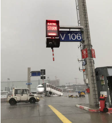
Abb. 10 Warntafel mit der Aufschrift „Electric-Storm-Warning“
