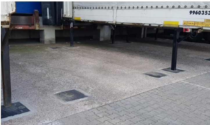
Abb. 3 Beispiel für eine tragfähige und rutschfeste Aufstandsfläche
