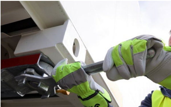
Abb. 27 Spannmutter festziehen
