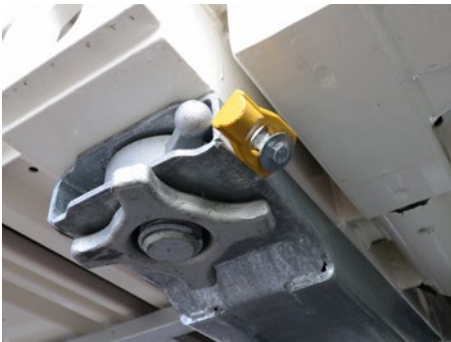
Abb. 14 Stellung der Fallsicherung gegen Rückfall
