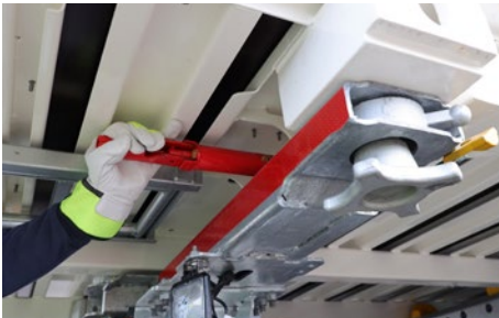
Abb. 6 Lösen der Stützbeinverriegelung
