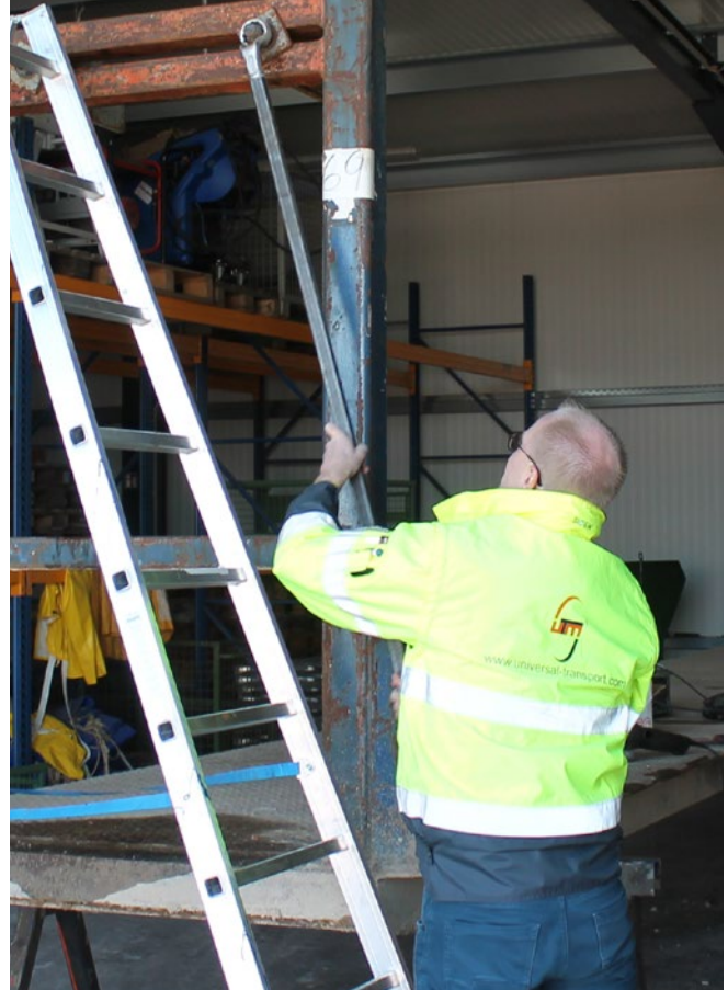
Abb. 17: Erzeugen von Reibungskräften zum Sichern der Fertigteile durch Anziehen der Schraubverbindung
