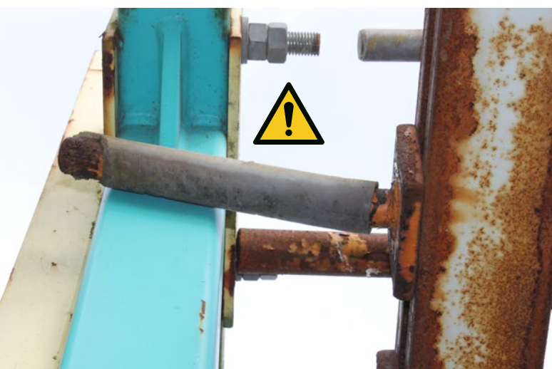
Abb. 13: Beschädigtes Arretierungselement einer IP
