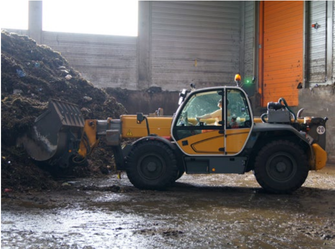
Abb. 18 Bagger zum Aushub kontaminierter Ma- terialien mit einer Schutzbelüftungs- anlage
