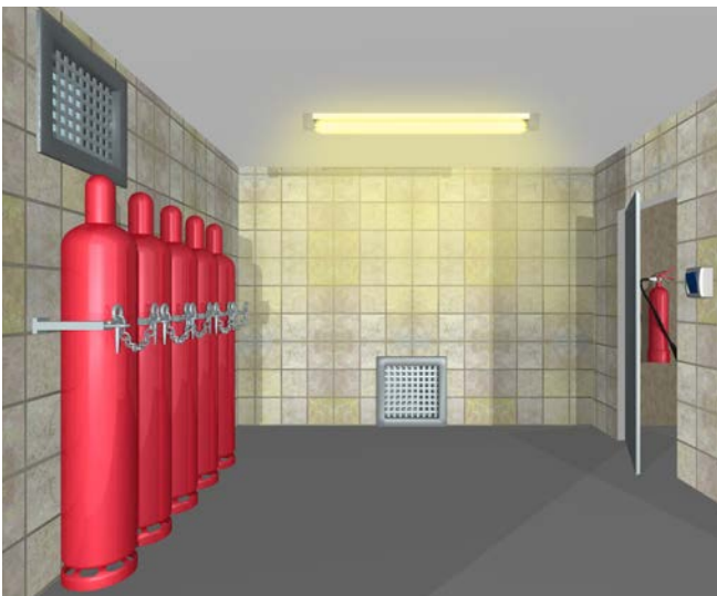
Abb. 34 Lagerung von Flüssiggasflaschen im Lagerraum
