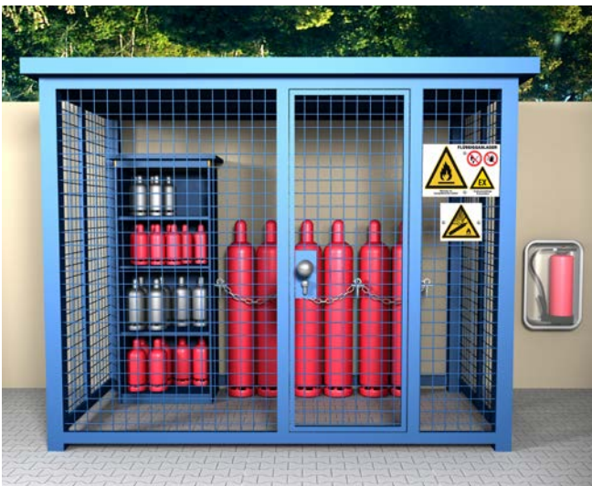
Abb. 32 Lagerung von Flüssiggasflaschen im Freien
