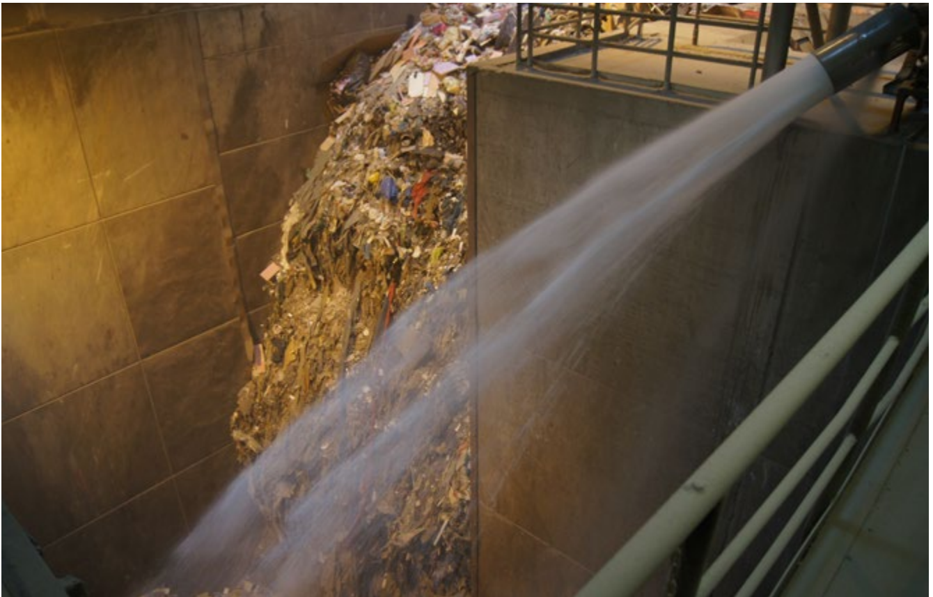
Abb. 14 Demonstration einer stationären Löschanlage im Müllbunker
